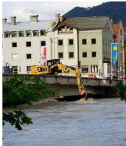
Die Bausubstanz der Brücke ist mittlerweile so schlecht, dass im Hochwasserfall kein Bagger auf der Brücke stehen dürfte.
