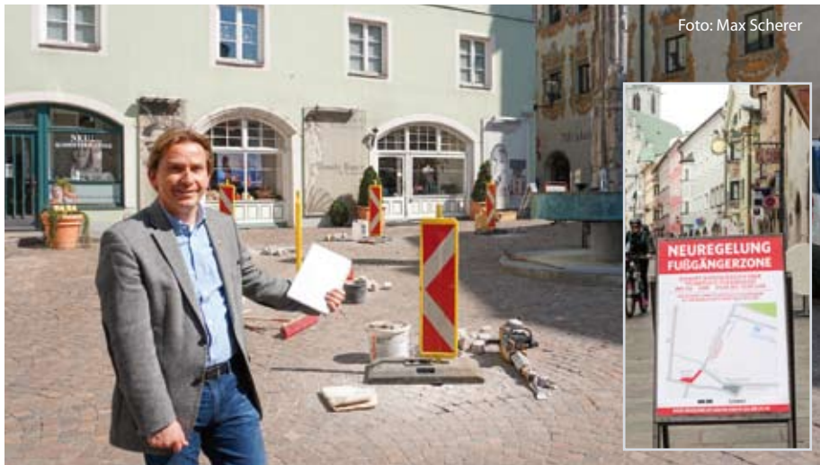
Am Stadtplatz und vor dem Rathaus wird eine dauerhafte Fußgängerzone errichtet.
