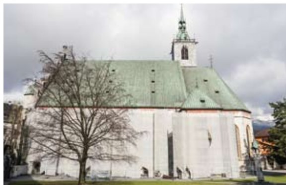
Teil 2 der Sanierung der Stadtpfarrkirche auf der Südseite beginnt demnächst.
