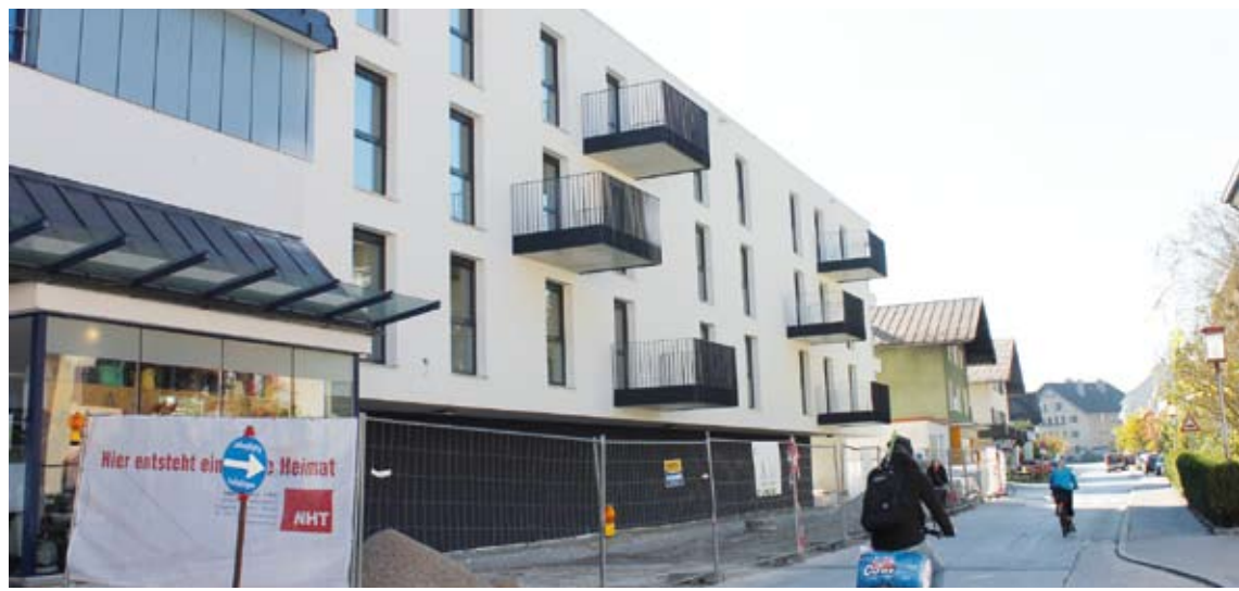
Bereits vor einem Jahr wurde mit dem Projekt 5-Euro-Wohnen begonnen.
