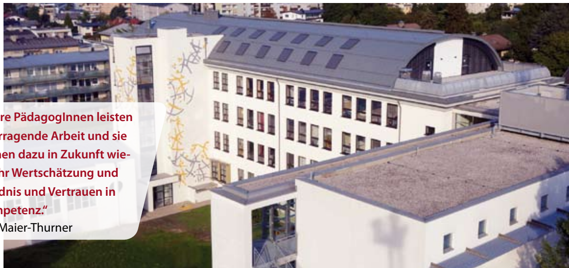
Das Gebäude der NMS Schwaz wurde saniert und erweitert.
