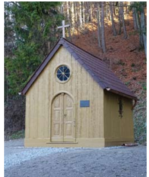
Die Maria-Zell-Kapelle wurde heuer im Sommer mit einem Lastenhubschrauber an den Eingang des Pflanzgartens versetzt und jetzt vom Bauhof restauriert.
