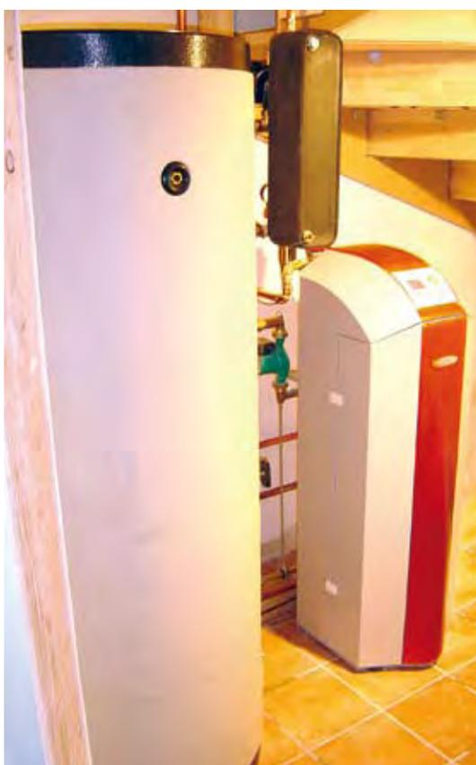
! Um einen möglichst effizienten Einsatz einer Wärmepumpe zu ermöglichen, ist ein Niedertemperatur-Verteilsystem (z. B. eine Fußbodenheizung) Voraussetzung. Denn je niedriger die Vorlauftemperatur, desto geringer ist der Stromverbrauch.
