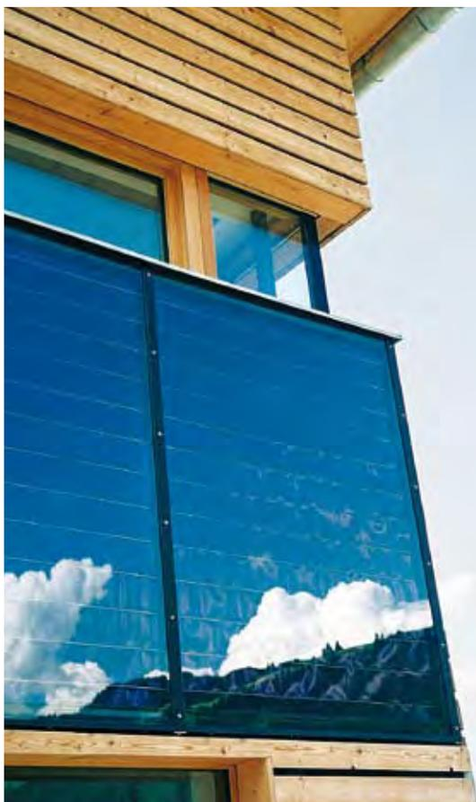
! Die meisten Tiroler Dächer verfügen über eine Dachneigung von maximal 30°, sind also für eine Dachintegration der Solaranlage zur Raumheizung nur bedingt geeignet. Die Integration der Kollektoren in die Fassade oder in den Balkon eignet sich besonders für Solaranlagen zur Heizungsunterstützung.
