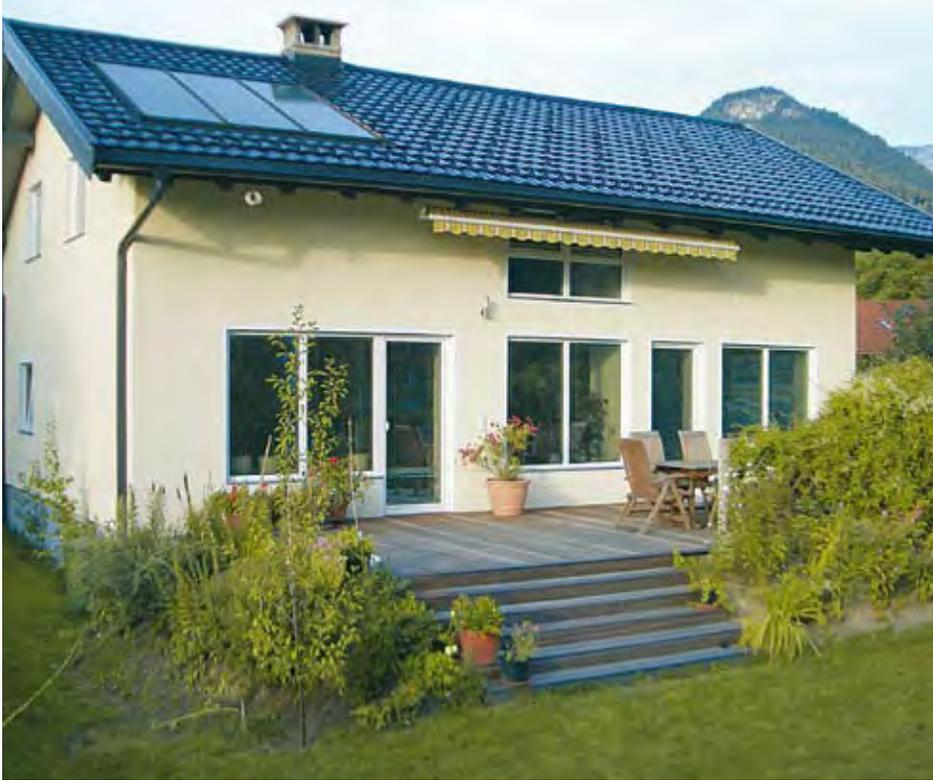
Abb 10 | 12 m<sup>2</sup> hochselektiver Kollektor ins Süddach integriert.
