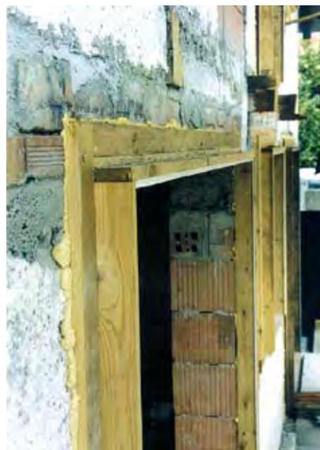
Abb 13 | Vorstehender Blindstock (Fensterrahmen) zur optischen Reduktion der Dämmstärke.
