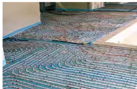
Abb 44 | Fußbodenheizung
