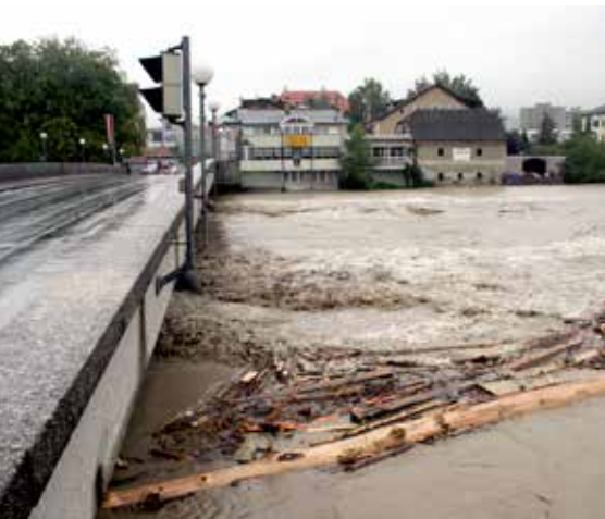
Die Steinbrücke stellt die größte Gefahr im Unterinntal bei Hochwasser durch Verklausung dar, wie etwa auf Bildern aus dem Jahr 2005.
