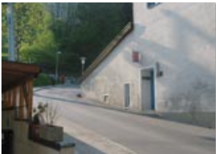
Die Engstelle bei der Auffahrt Arzbergstraße wird beseitigt.
