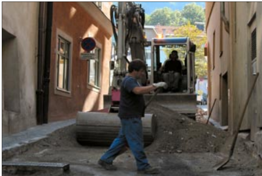
Die Arbeiten in der Burggasse haben bereits begonnen.
