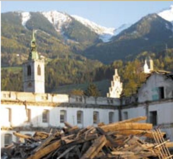
Austria Tabak-Werke: Es wurde ein Entwicklungskonzept erstellt, der Abbruch ist im Gange und ein Architektenwettbewerb ausgeschrieben.
