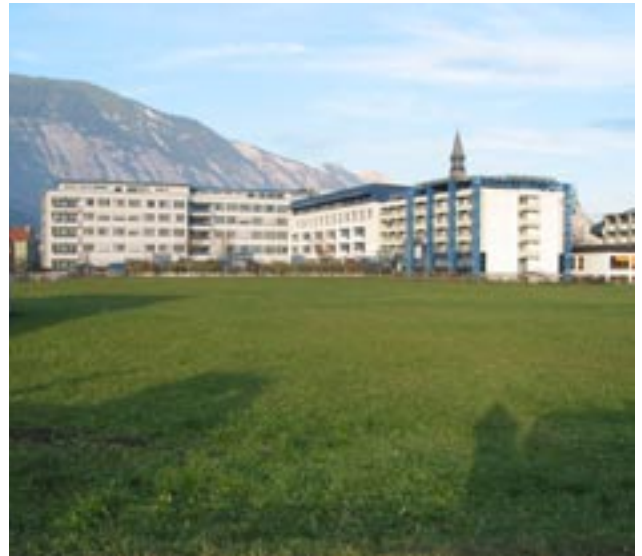
Auf dem Areal hinter dem Bezirkskrankenhaus wird das neue Heeresspital gebaut.
