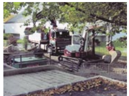
Die Heizanlage am Johannes-Messner-Weg wurde ausgebaut.
