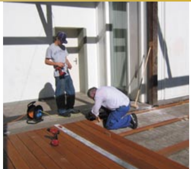
Bodenverlegearbeiten beim Postpark durch Bauhofmitarbeiter.
