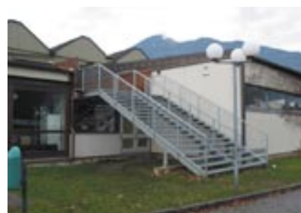
Sporthalle Ost: die Sicherheit wurde u.a. durch Fluchstiegen erhöht.
