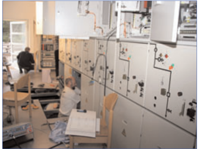
Instandsetzung der 5 kV Schaltanlage durch die Firma Siemens.
