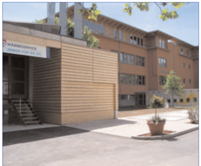
Im Bild der neue, schön gestaltete Außenbereich vor der Hack-schnitzel-Heizzentrale Schul- und Pfarrzentrum Schwaz-Ost.
