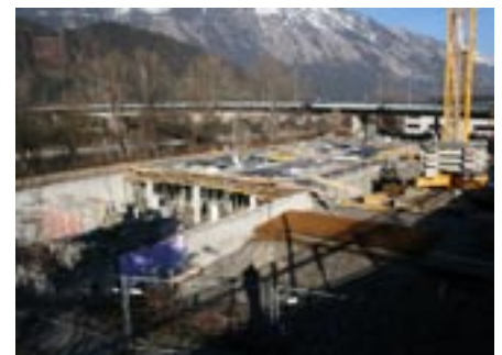
Im Bau: das neue Feuerwehrgerätehaus.
