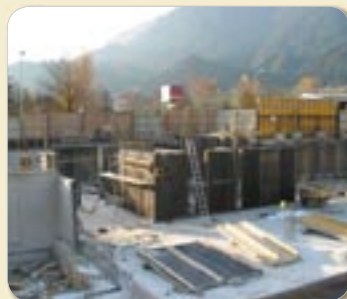
Die Baustelle Kompetenzzentrum.
