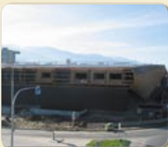
Die Baustelle Interspar.
