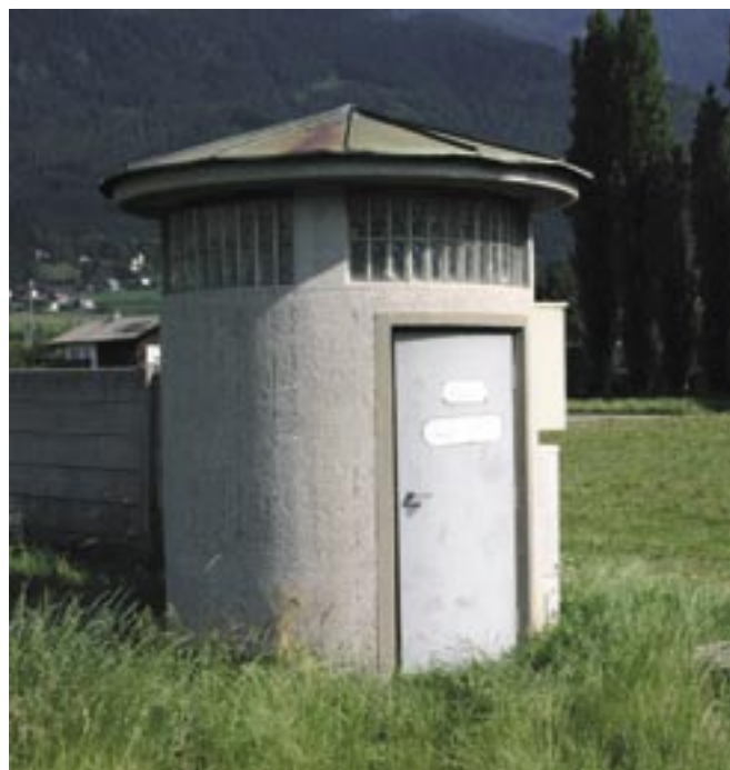
Die alte Tiefbrunnenanlage am ehemaligen Sportplatz wurde jetzt ganz abgetragen.
