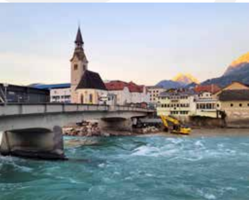
Die Einzelteile für die Behelfsbrücke werden angeliefert und auf der alten Steinbrücke gelagert.
