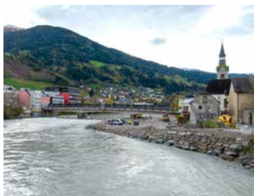
Ein Blick aus der Luft am 02. November 2023: Die Inselfschüttung ist fertiggestellt, und die Betonierarbeiten am Pfeiler der Behelfsbrücke beginnen.
