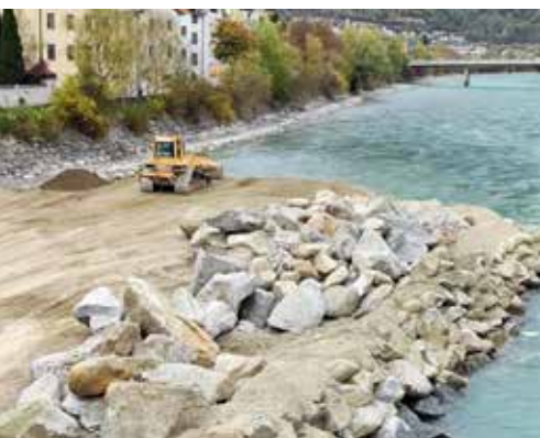
Die Inselfschüttung wird nach und nach fertiggestellt. Hochwasser setzt die Schüttung unter Wasser. Die dadurch verlorene Zeit muss wieder aufgeholt werden.
