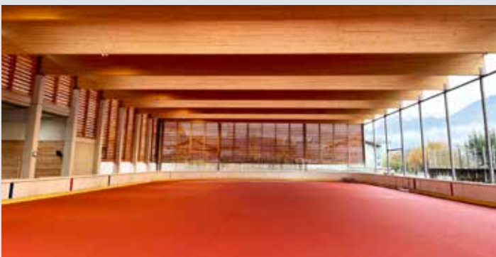
Ein Blick auf den neuen Mehrzwecksportplatz, kurz bevor mit den Arbeiten für die Herstellung der Eisfläche begonnen wurde.
