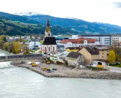
Ein Blick aus der Luft am 02. November 2023: Die Inselfschüttung ist fertiggestellt, und die Betonierarbeiten am Pfeiler der Behelfsbrücke beginnen.
