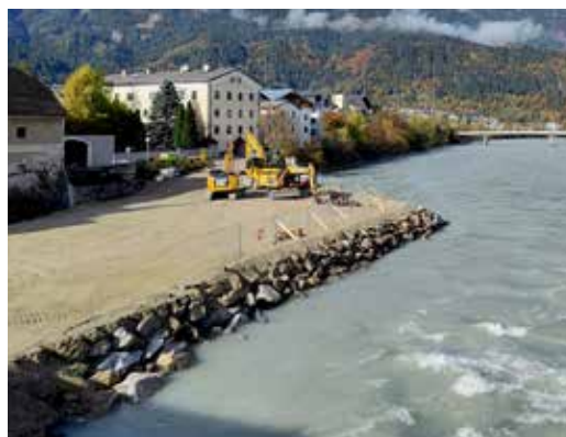
Die Inselfschüttung wird nach und nach fertiggestellt. Hochwasser setzt die Schüttung unter Wasser. Die dadurch verlorene Zeit muss wieder aufgeholt werden.
