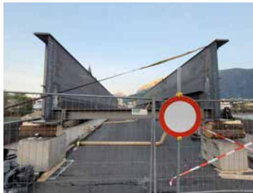
Die Einzelteile für die Behelfsbrücke werden angeliefert und auf der alten Steinbrücke gelagert.
